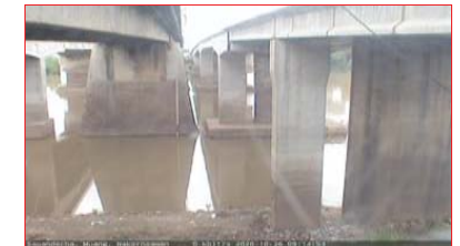
สถานีสะพานเดชาติวงศ์ ต.ปากน้ำโพ อ.เมือง จ.นครสวรรค์ (ลุ่มน้ำเจ้าพระยา)
