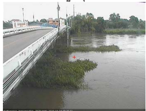
สะพานหลวงพ่เป็น - อ.นครไชยศรี จ.นครปฐม (ลุ่มน้ำท่าจีน)
