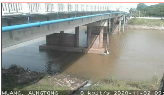
สถานีศาลากลางอ่างทอง ต.บางแก้ว อ.เมือง จ.อ่างทอง (ลุ่มน้ำเจ้าพระยา)
