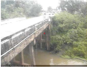
สถานีคลองตะโหมด - อ.ตะโหมด จ.พัทลุง (ลุ่มน้ำทะเลสาบสงขลา)
