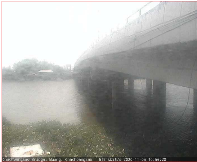
สถานีเขิงสะพานฉะเชิงเทรา ต.หน้าเมือง อ.เมือง จ.ฉะเชิงเทรา (ลุ่มน้ำบางปะกง - แม่น้ำบางปะกง)
