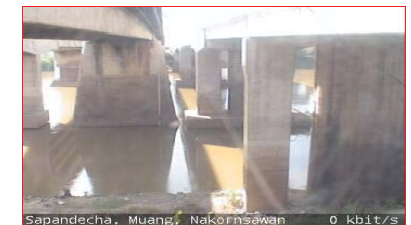
สถานีสะพานคชาติวังศ์ ต.ปากน้ำโพธิ์ อ.เมือง จ.นครสวรรค์ (ลุ่มน้ำเจ้าพระยา)
