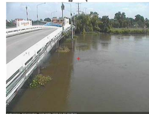
สะพานหลวงพ่เป็น - อ.นครไชยศรี จ.นครปฐม (ลุ่มน้ำท่าจีน)
