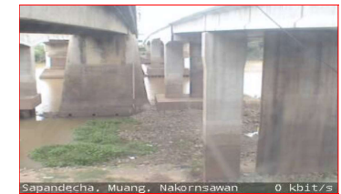
สถานีสะพานเดชาติวงศ์ ต.ปากน้ำโพ อ.เมือง จ.นครสวรรค์ (ลุ่มน้ำเจ้าพระยา)
