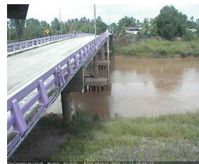
สะพานเฉลิมพระเกียรติ ร.9 48 พรรษา อ.เมือง จ.พิจิตร (ลุ่มน้ำ่าน)
