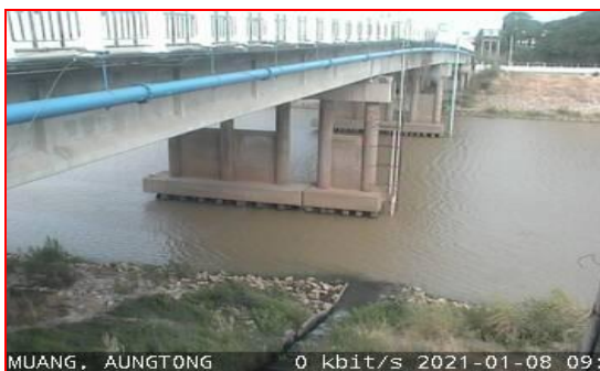
สถานีศาลากลางอ่างทอง ต.บางแก้ว อ.เมือง จ.อ่างทอง (ลุ่มน้ำเจ้าพระยา)
