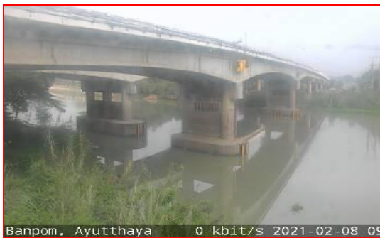
สถานีบ้านป้อม ต.บ้านป้อม จ.พระนครศรีอยุธยา (ลุ่มน้ำเจ้าพระยา)
