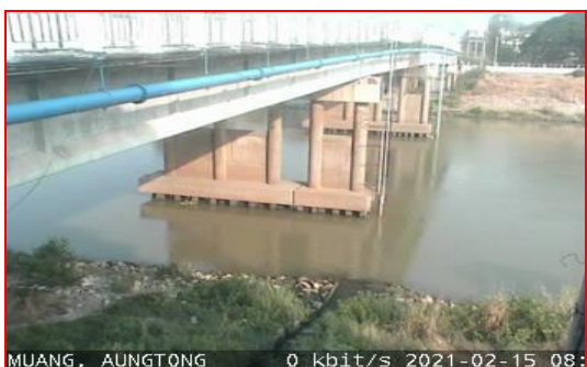
สถานีศาลากลางอ่างทอง ต.บางแก้ว อ.เมือง จ.อ่างทอง (ลุ่มน้ำเจ้าพระยา)
