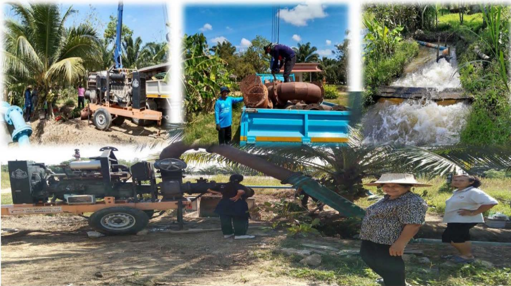
สำนักงานทรัพยากรน้ำภาค ๑๐ ส่วนบริการจัดการน้ำ ดำเนินการประตู่ อำเภอเมือง จังหวัดสุราษฎร์ธานี โทร. ๐ ๗๗๒๐ ๐๗๕๕
