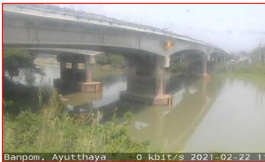
สถานีบ้านป้อม ต.บ้านป้อม จ.พระนครศรีอยุธยา (ลุ่มน้ำเจ้าพระยา)
