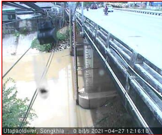
สถานีคลองอุตะภาคตอนล่าง - ต.หาดใหญ่ อ.หาดใหญ่ จ.สงขลา (ลุ่มน้ำทะเลสาบสงขลา)
