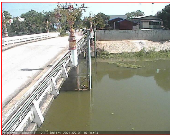
สะพานพระแม่ย่า ต.ธานี อ.เมือง จ.สุโขทัย (ลุ่มน้ำยม)
