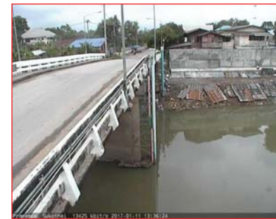
สถานีสะพานพระเมเย่อ อ.เมือง จ.สุโขทัย (ลุ่มน้ำยม)
