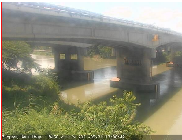
บ้านป้อม ต.บ้านป้อม จ.พระนครศรีอยุธยา (ลุ่มน้ำเจ้าพระยา)
