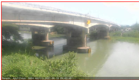
บ้านป้อม ต.บ้านป้อม จ.พระนครศรีอยุธยา (ลุ่มน้ำเจ้าพระยา)
