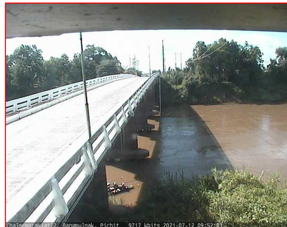
สะพานเฉลิมพระเกียรติ ร.9 72 พระยา ต.เนินมะกอก อ.บางมูลนาก จ.พิจิตร (ลุ่มน้ำน่าน)
