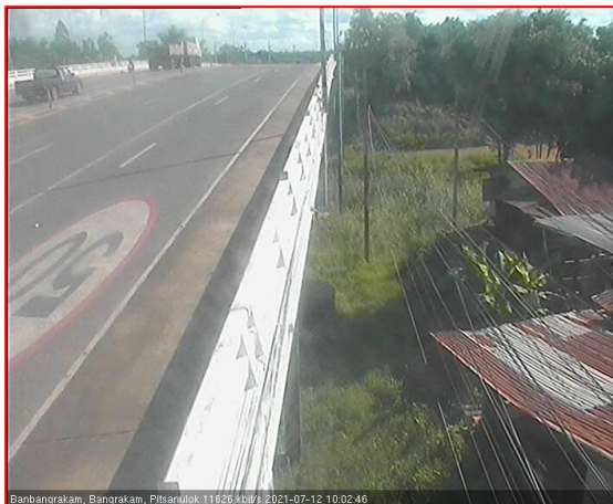
สะพานบ้านบางระกำ ต.บางระกำ อ.บางระกำ จ.พิษณุโลก (ลุ่มน้ำยม)
