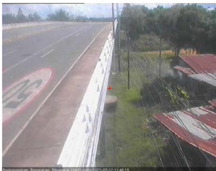
สะพานบางระกำ - อ.บางระกำ จ.พิษณุโลก (ลุ่มน้ำยม)
