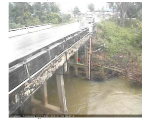
สถานีคลองตะโหมด - อ.ตะโหมด จ.พัทลุง (ลุ่มน้ำทะเลสาบสงขลา)
