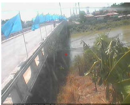
สะพานบ้านโพทะเล - อ.โพทะเล จ.พิจิตร (ลุ่มน้ำยม)
