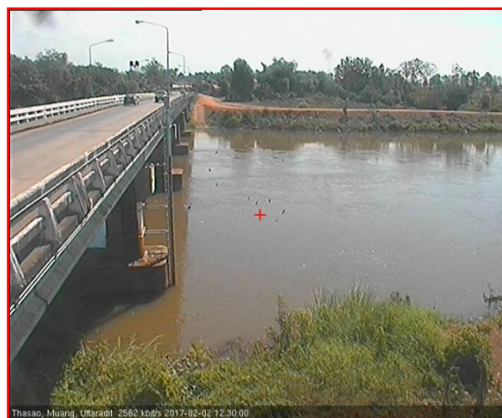
สถานีสะพานท่าเสา อ.เมือง จ.อุดรดิตถ์ (ลุ่มน้ำน่าน)
