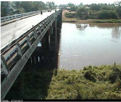
สะพานท่าเสา - อ.เมือง จ.อุตรดิตถ์ (ลุ่มน้ำ่าน)
