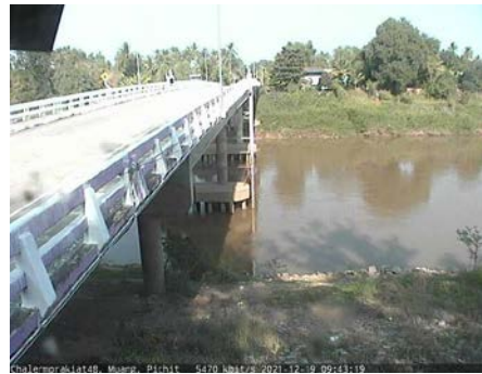
สะพานเฉลิมพระเกียรติ 48 พรรษา อ.เมือง จ.พิจิตร (ลุ่มน้ำ่าน)
