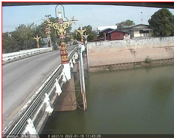
สะพานพระแม่ย่า ต.ธานี อ.เมือง จ.สุโขทัย (ลุ่มน้ำยม)
