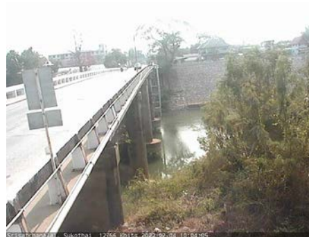
สะพานศรีรัตนาลัย - อ.ศรีรัตนาลัย จ.สุโขทัย (ลุ่มน้ำยม)
