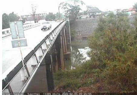
สะพานศรีรัตนาลัย - อ.ศรีรัตนาลัย จ.สุโขทัย (ลุ่มน้ำยม)
