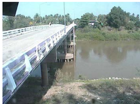
สะพานเฉลิมพระเกียรติ 48 พรรษา อ.เมือง จ.พิจิตร (ลุ่มน้ำ่าน)
