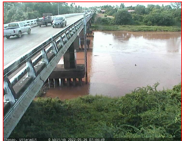
สะพานท่าเสา
