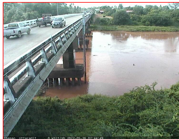
สะพานท่าเสา
