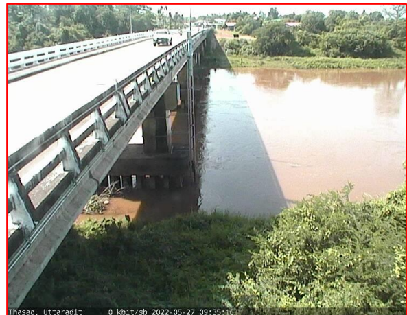
สะพานท่าเสา
