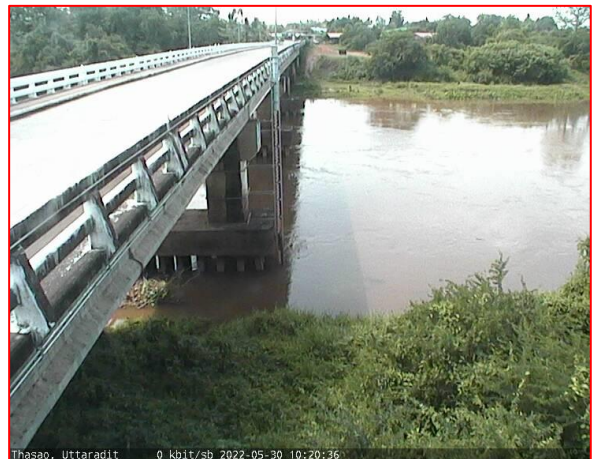
สะพานท่าเสา
