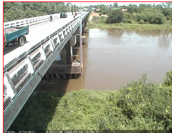
สะพานท่าเสา
