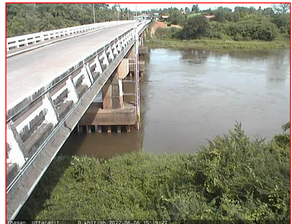
สะพานท่าเสา
