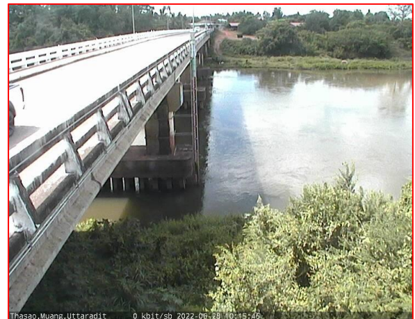
สะพานท่าเสา
