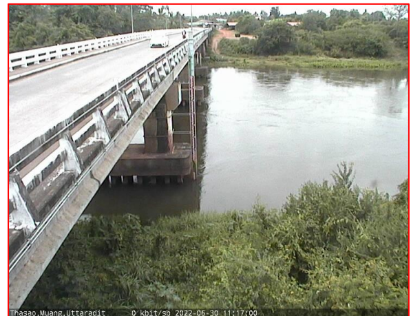
สะพานท่าเสา
