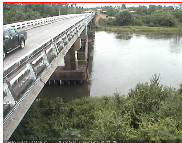
สะพานท่าเสา
