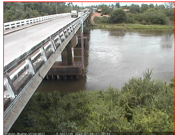
สะพานท่าเสา
