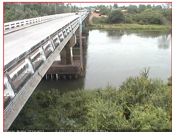
สะพานท่าเสา
