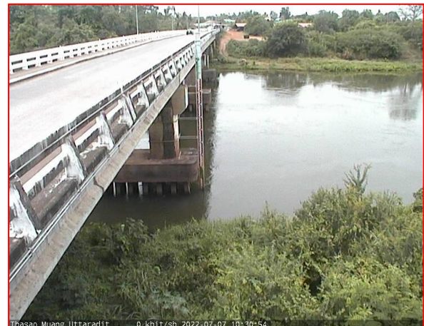
สะพานท่าเสา
