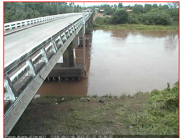
สะพานท่าเสา
