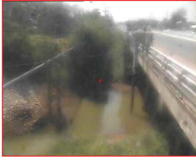
สถานีห้วยหลวง ต.หม่ม อ.เมือง จ.อุดรธานี(ลุ่มน้ำโขง)
