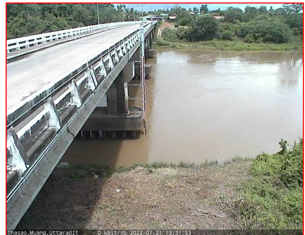
สะพานท่าเสา ต.ท่าเสา อ.เมือง จ.อุตรดิตถ์ (ลุ่มน่าน)
