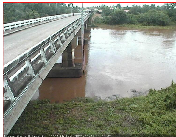
สะพานท่าเสา ต.ท่าเสา อ.เมือง จ.อุตรดิตถ์ (ลุ่มน้ำน่าน)
