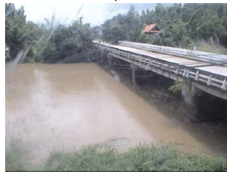
บ้านเหล่านกขุม - อ.เมือง จ.ขอนแก่น (ลุ่มน้ำชี)
