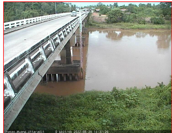
สะพานท่าเสา
