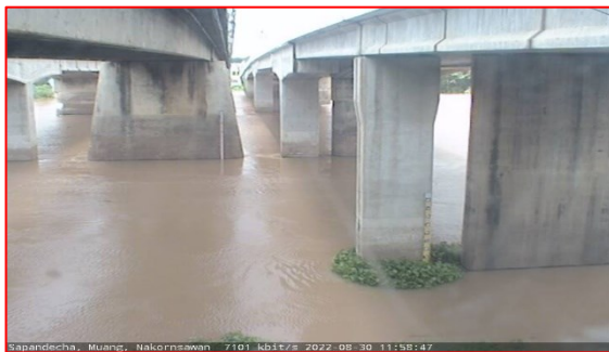
สะพานเดชาวาศ์ ต.ปากน้ำโพธิ์ อ.เมือง จ.นครสวรรค์ (ลุ่มน้ำเจ้าพระยา)
