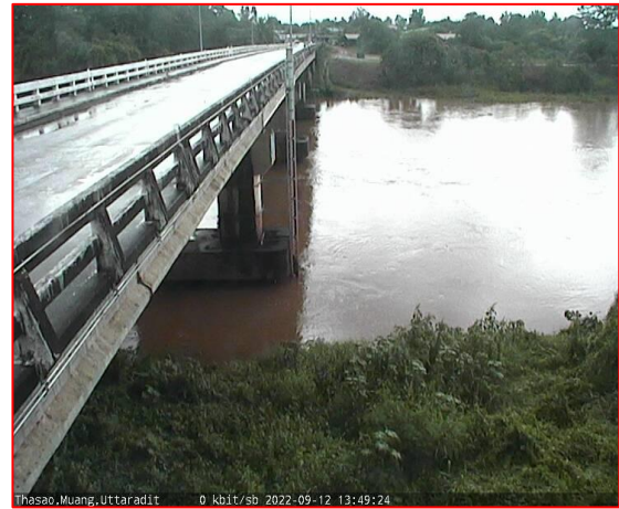
สะพานท่าเสา
