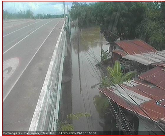
สะพานบ้านบางระกำ
