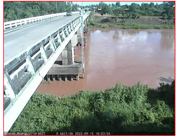
สะพานท่าเสา ต.ท่าเสา อ.เมือง จ.อุตรดิตถ์
